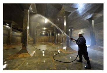
Fase disinfezione ad applicazione diretta (spruzzatura) 100-800 mg/l
